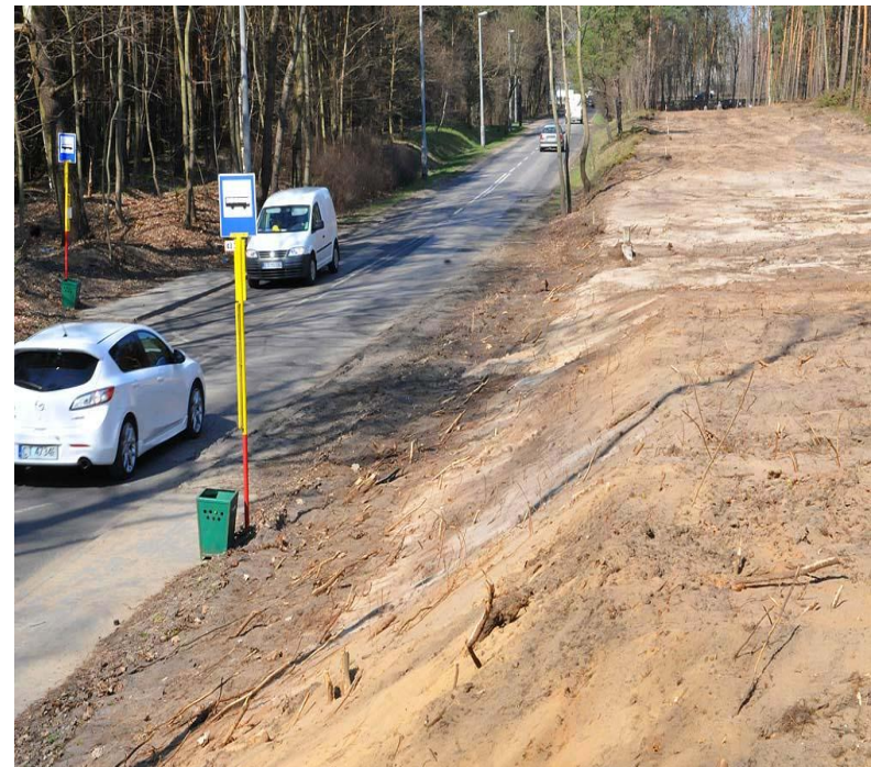
Przebudowa ul. Sz. Okreźna
