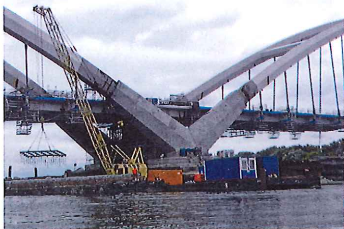
Fot. 4. Podpora w nurcie rzeki. Montaż pomostów w trakcie realizacji. Źródło: Miejski Zarząd Dróg w Toruniu
