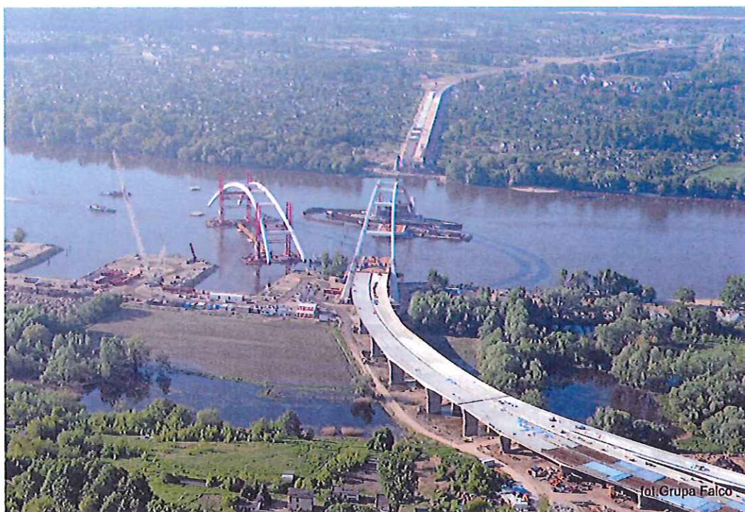
Fot. 6. Transport południowego przęsła nr 2 Źródło: Miejski Zarząd Dróg w Toruniu. Autor: Grupa Falco
