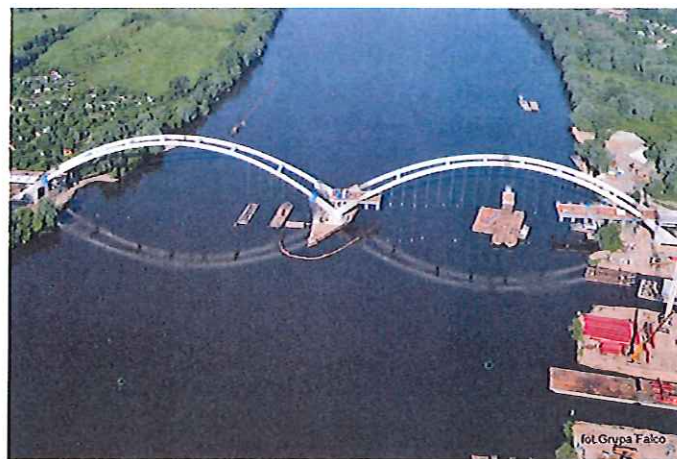
Fot. 8. Zamontowane przęsła dźwigarów łukowych na podporach stałych mostu. Źródło: Miejski Zarząd Dróg w Toruniu. Autor: Grupa Falco
