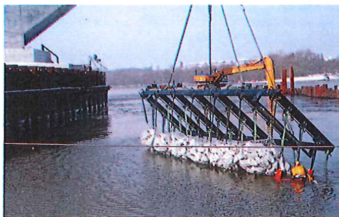
Fot. 5. Prace przy umacnianiu wyspy centralnej matercem kamiennym Źródło: Miejski Zarząd Dróg w Toruniu
