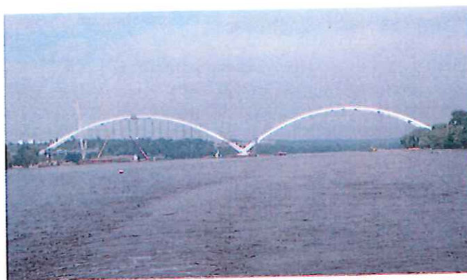
Fot. 3. Zamontowane przęsła nr 1 i nr 2 dźwigarów łukowych na podporach stalowych. Przygotowania do montażu pomostu Źródło: Miejski Zarząd Dróg w Toruniu.
