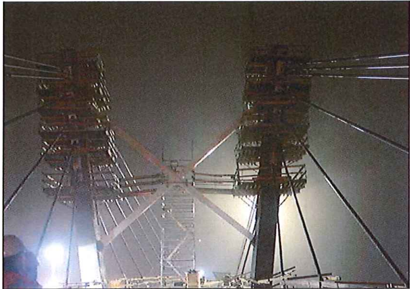
Fot. 6 | Naciąg wantu pylonu podpory nr P2 (fot. K. Dudek)
