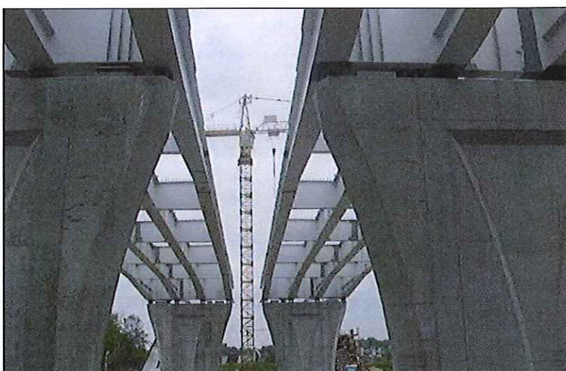
Fot. 3 | Konstrukcje stalowe przęseł ułożone na podporach nr 18 i 19 estakad E3 (fot. A. Kowalski)
