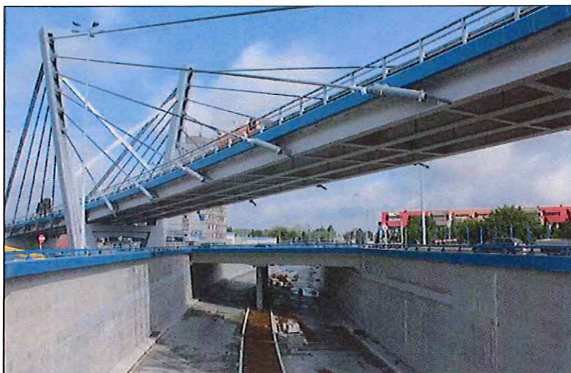
Fot. 1 | Estakada nad tunelem (fot. K. Dudek)
