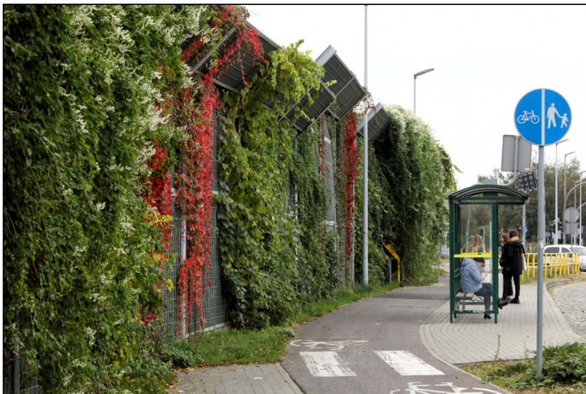
Fot. 49. Jesienne barwy ekranów akustycznych
