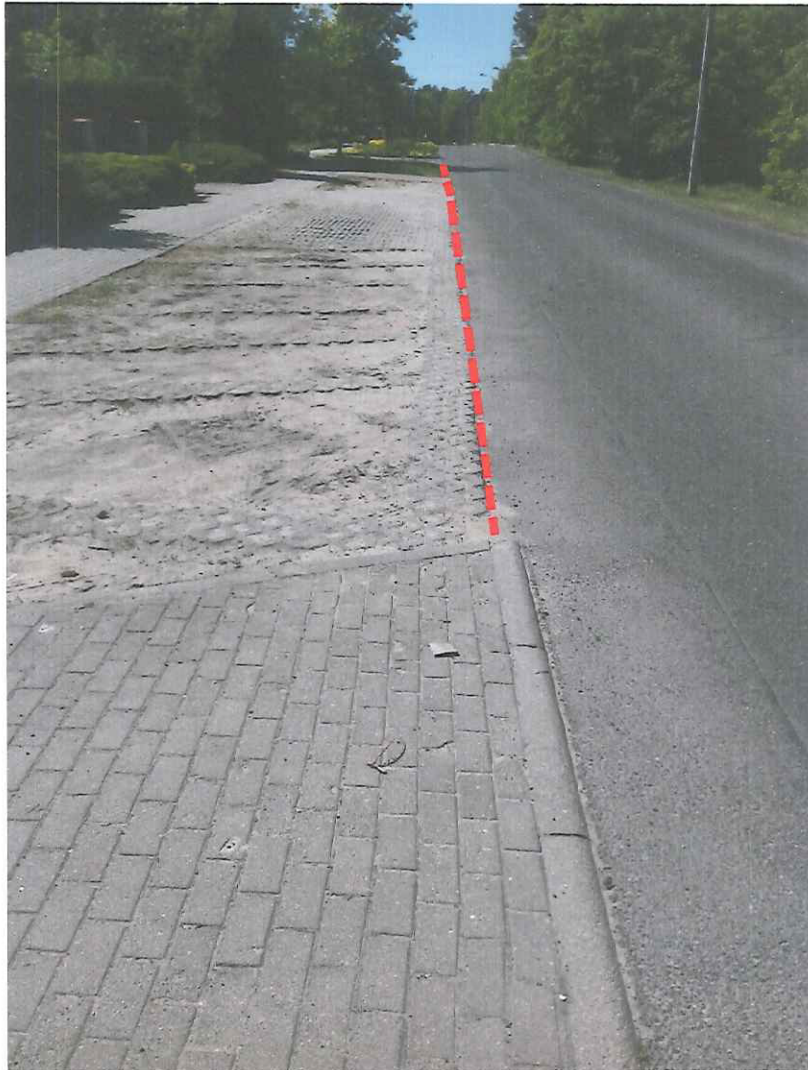
Ul. Zdrojowa: krawężnik przy posesji Zdrojowej 18,20 i 22
