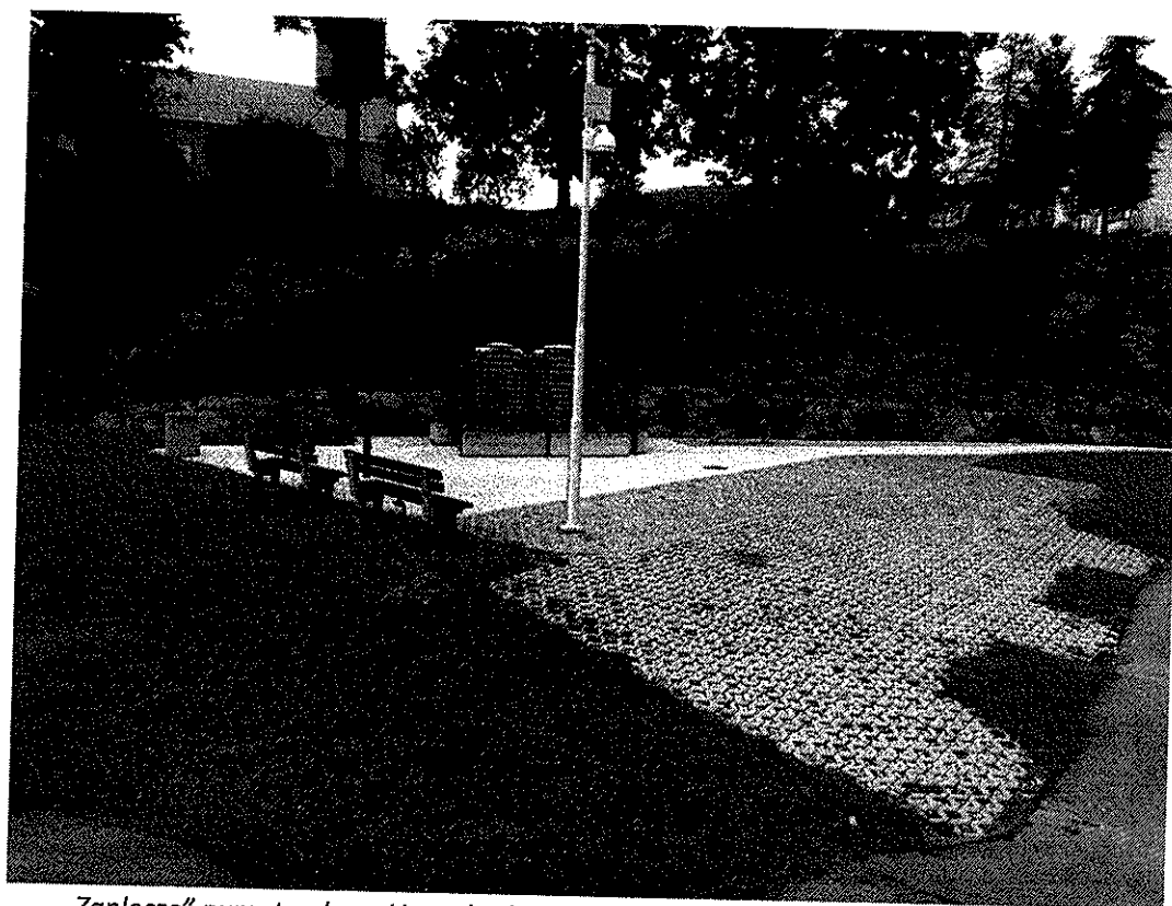
„Zaplecze” pumptracku w Ustrzykach Dolnych (ławki, kosz na śmieci, stojaki, toalety) (fot. Błażej Kozicki)
