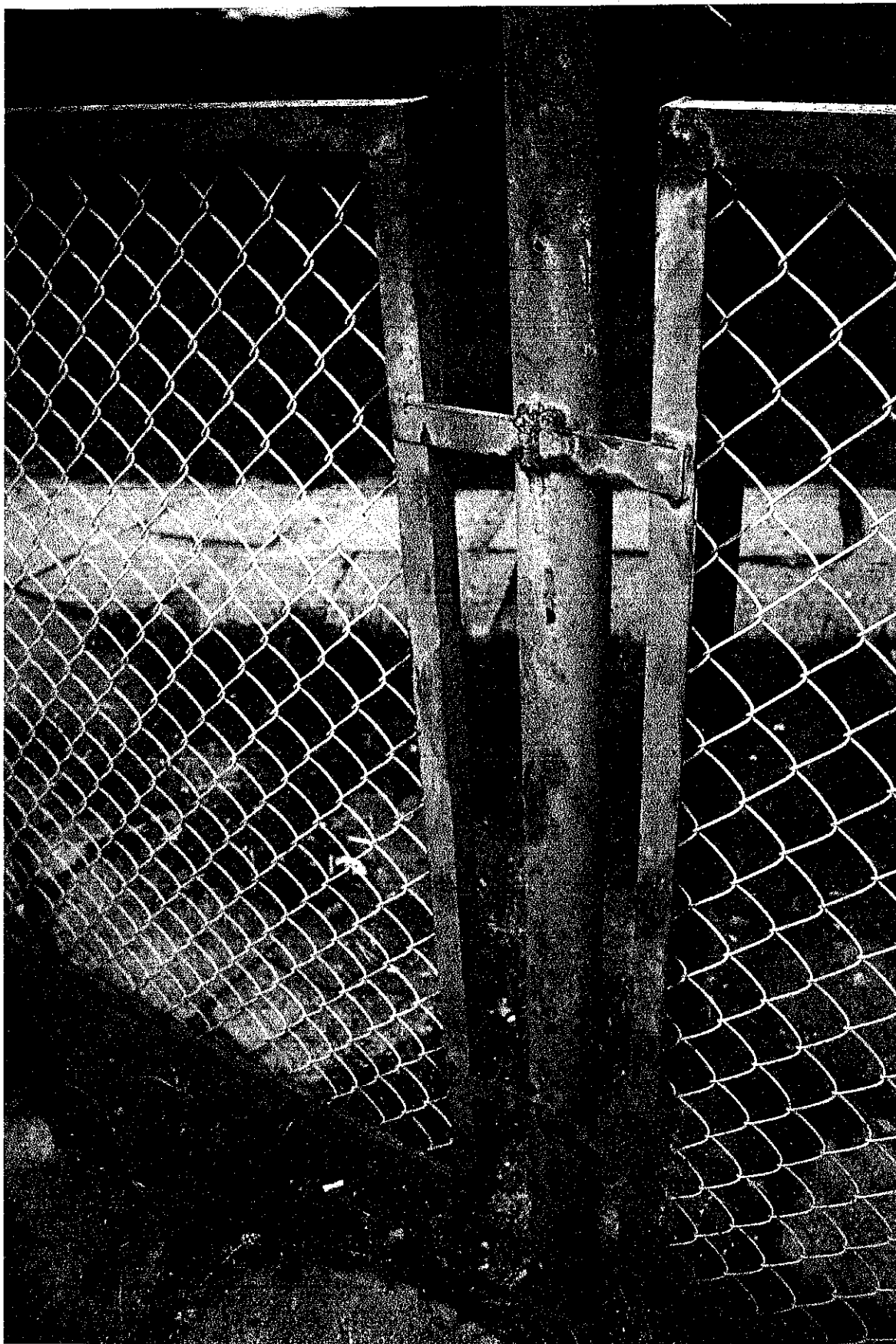
Zdjęcie nr 3. Stan ogrodzenia
