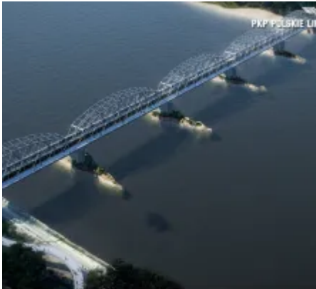
Kładka rowerowo-pieszna wzdłuż mostu im. Ernesta Malinowskiego
