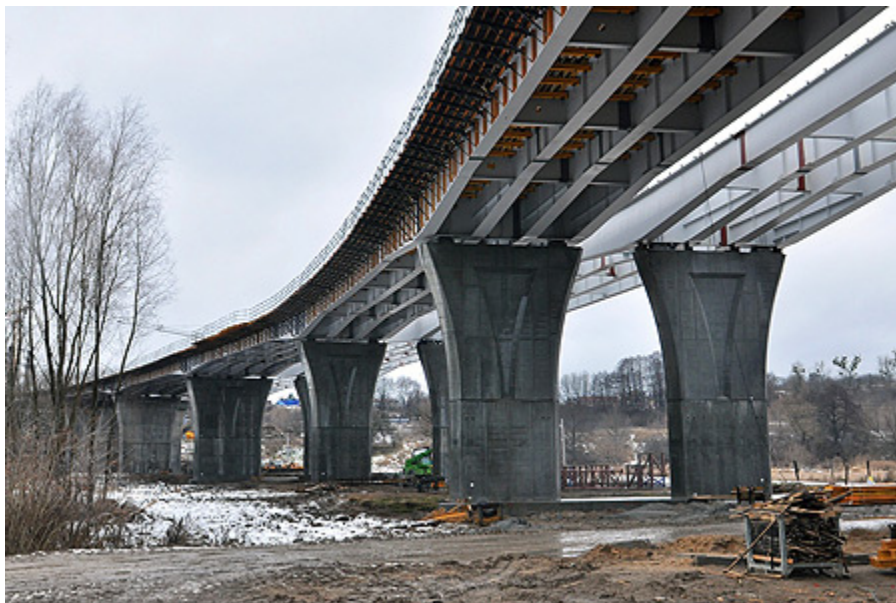
Na lewym brzegu trwa zbrojenie i szalowanie kolejnych sekcji mostu
