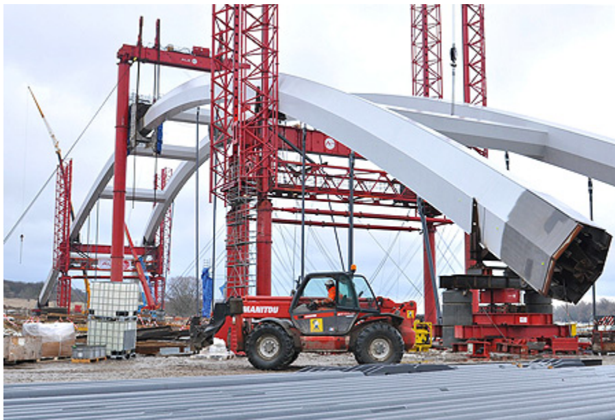
Stalowe przęśta mają po 270 m długości
