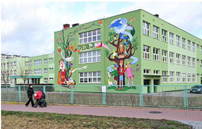
Szkoła Podstawowa nr 28 po termomodernizacji
