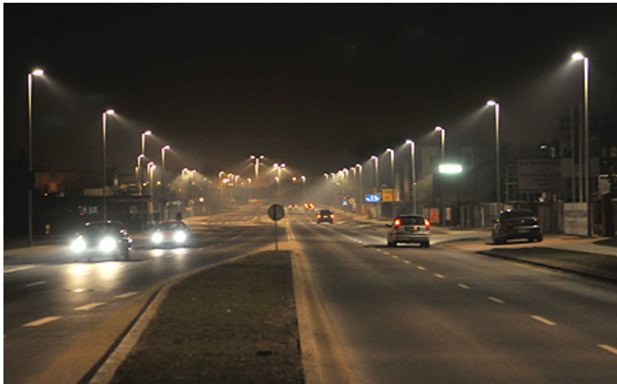
Zmodernizowana i oświetlona ulica Polna
