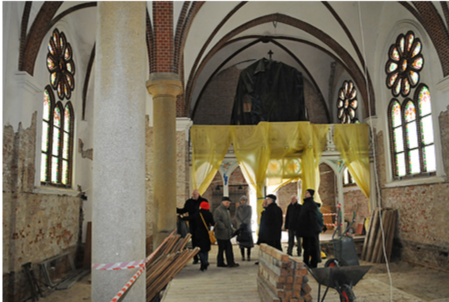
Kilka dni temu trwające w kościele prace remontowe oglądali prezydent Torunia i miejski konserwator zabytków
