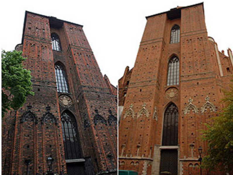
Wieża toruńskiej katedry śś. Janów przed i po renowacji
