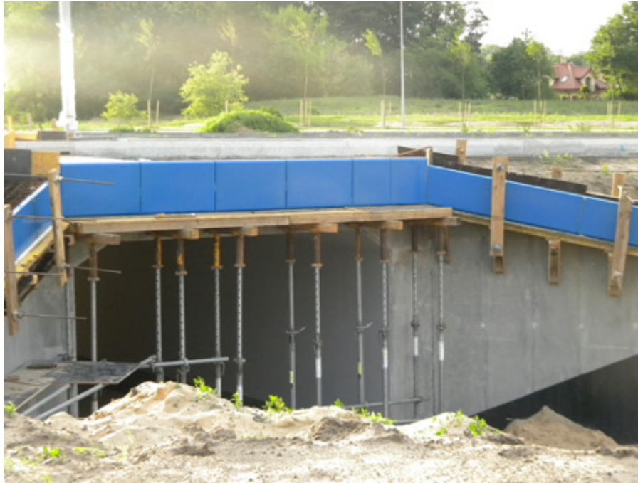
Prace trwają także przy wylocie tunelu
