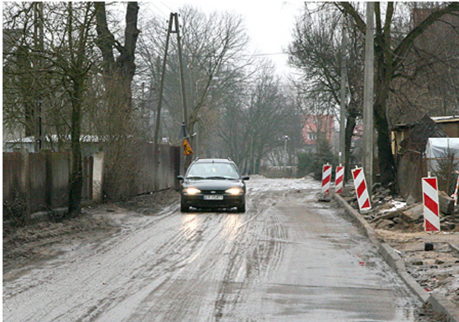
Przebudowa ul. Rudackiej ruszy jeszcze w tym roku
