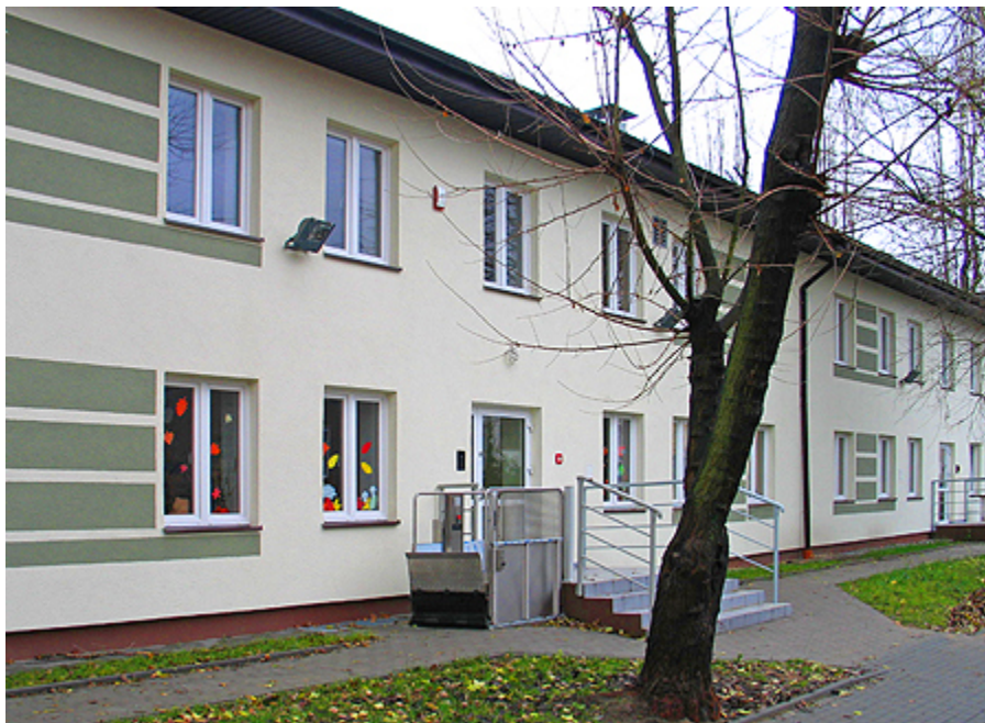
Budynek przy ul. Moczyńskiego zaadaptowany na przedszkole
