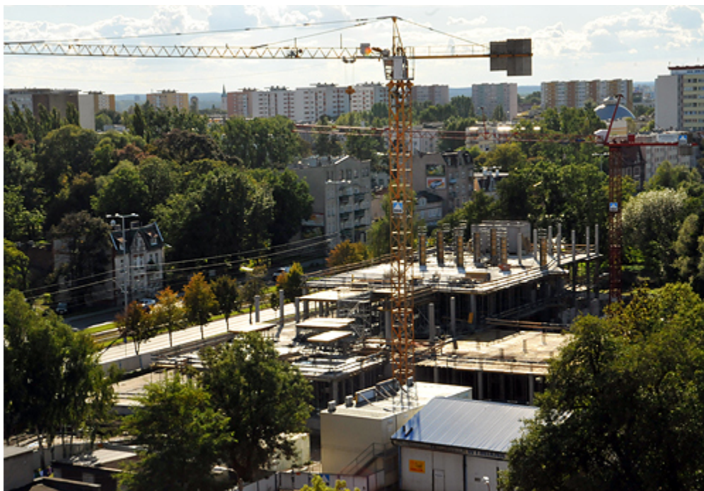
Budowa obiektu już trwa
