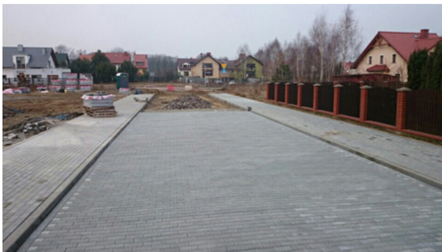
W trakcie prac
