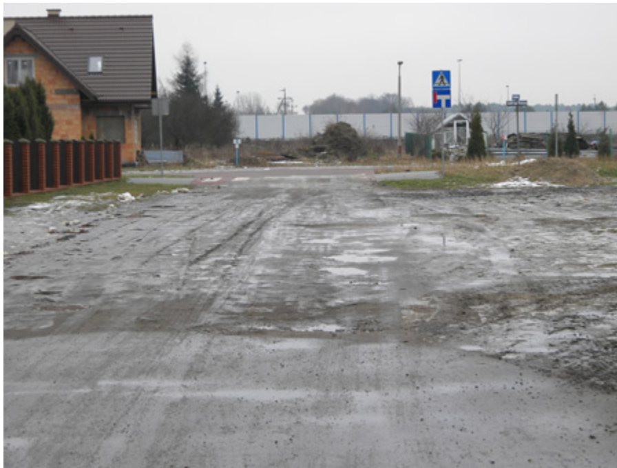
Ul. Zagłoby przed pracami
