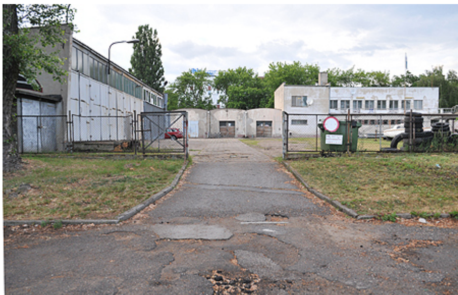
Budynki starej przystani AZS zostaną rozebrane
