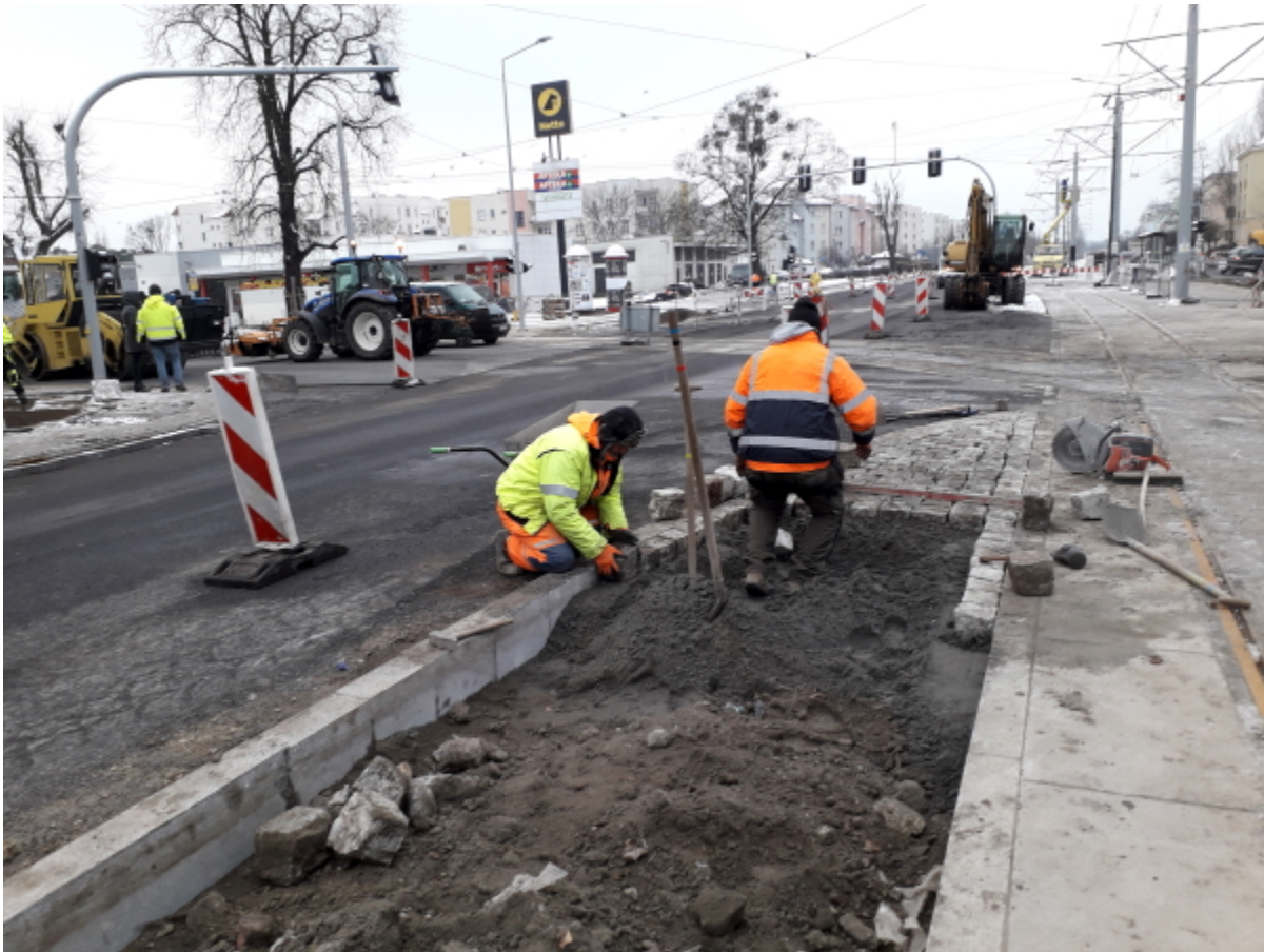
Prace przy torowisku na ulicy Broniewskiego
