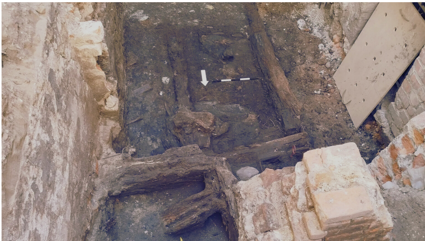
W trakcie prac na dziedzińcu Domu Kopernika odsłonięto świetnie zachowane konstrukcje drewniane dawnego przejazdu, prowadzącego od ul. Ducha Świętego na podwórze, a także studnię wykonaną z grubych dranic. Fot. Muzeum Okręgowe w Toruniu
