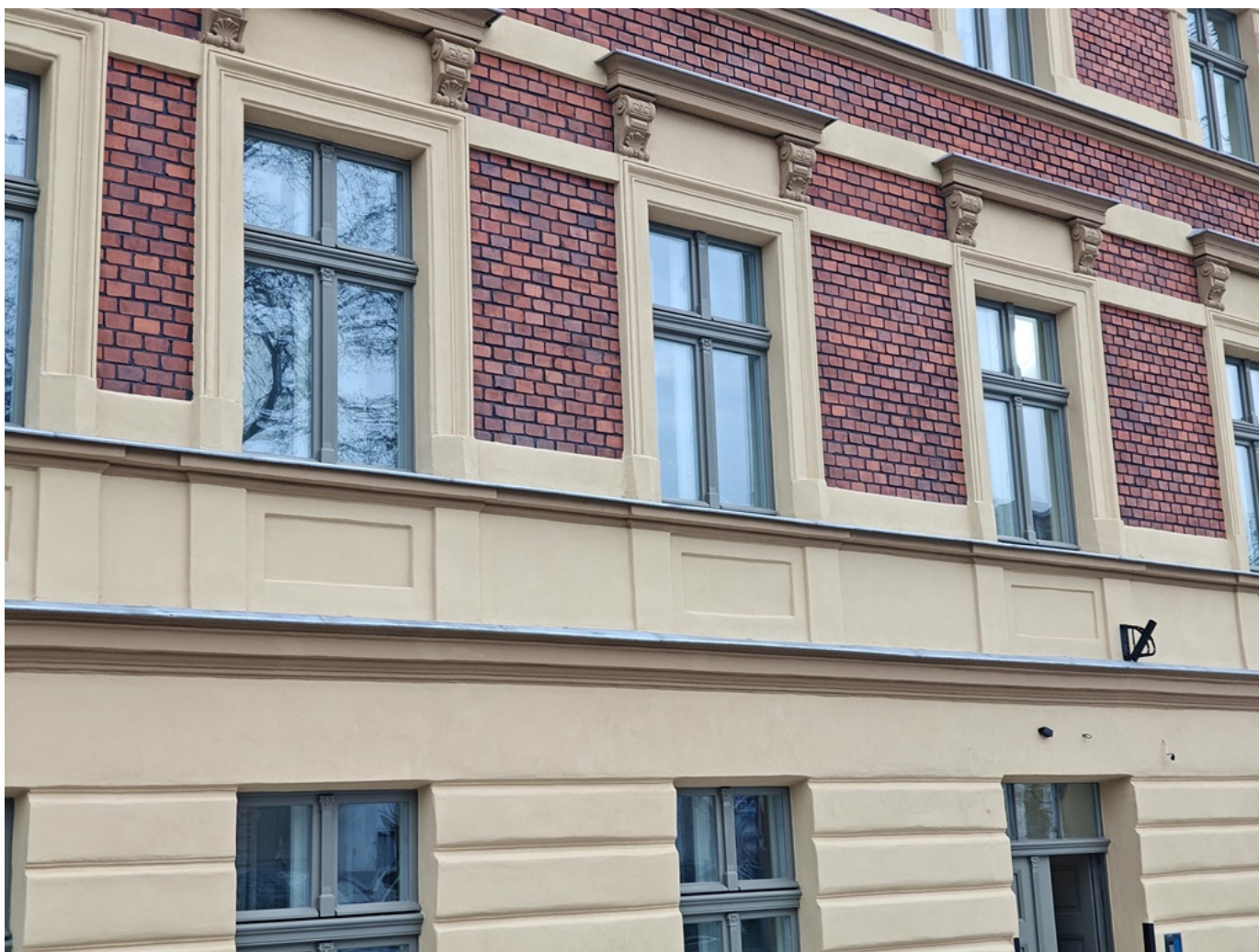
Dobiegają końca prace przy ul. Poznańskiej 66
