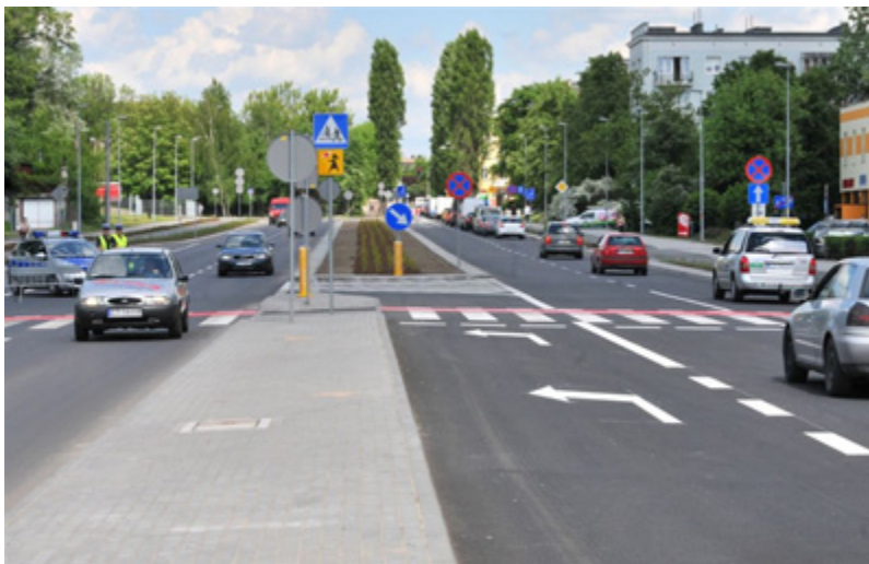
Przebudowana ul. Bema - szybciej i bezpieczniej
